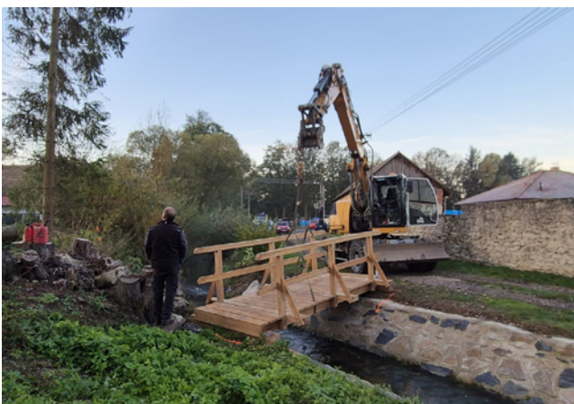
Na Podhorce byl přes Lověťtinský potok položen nový mostek.
