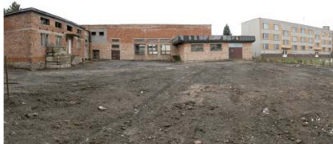
Vyčištěné prostory u nedostavěného víceúčelového zařízení, které doposud sloužily jako skládka.
