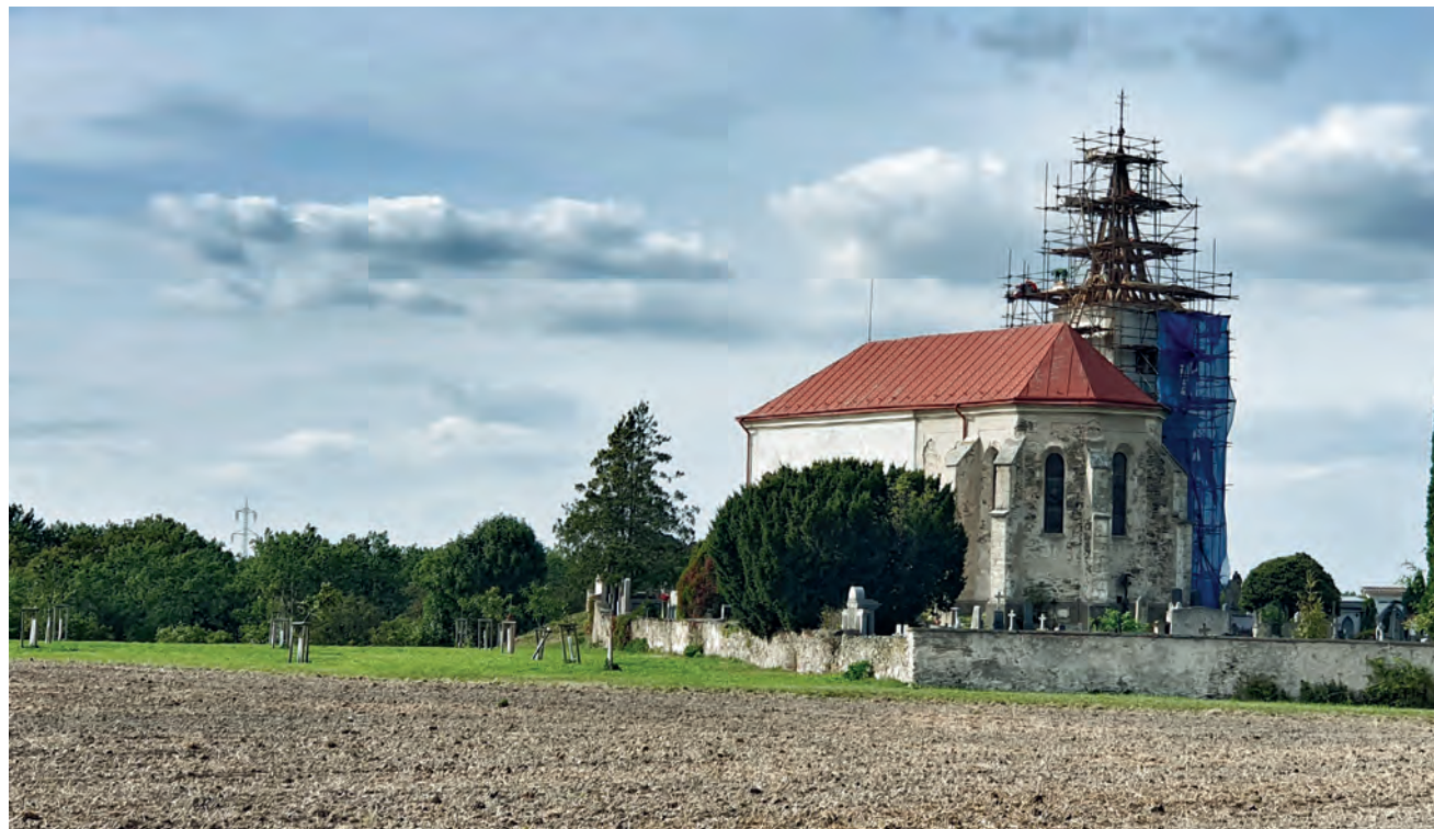
Na věži kostela byly vyměněny napadené trámy, které pokryje bednění ze širokých prken. Plechovou krytinu nahradí břidlice, jež na kostele původně byla.
