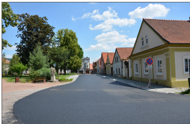
❑ Na jižní straně náměstí byl položen nový asfaltový povrch
