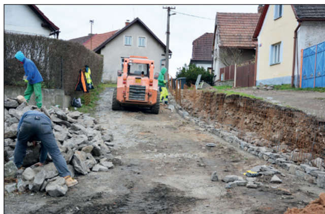
❑ V Souběžné ulici byla započata rekonstrukce štětové cesty
