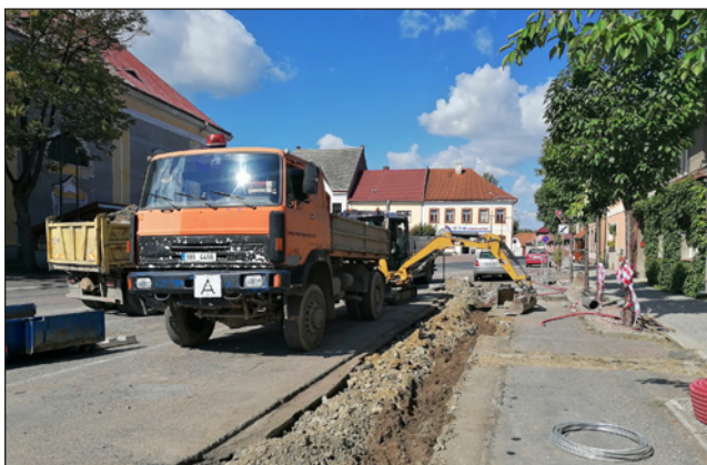
❑ Celý rok pokračovala výstavba hlavních řádů kanalizace
