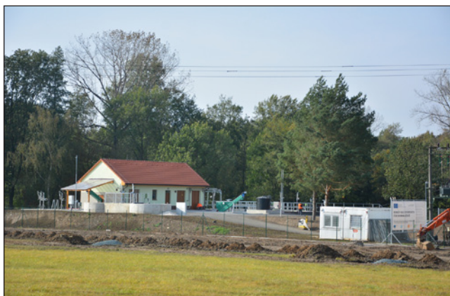
❑ Čistírna odpadních vod – provoz zahájen 31.8.2020
