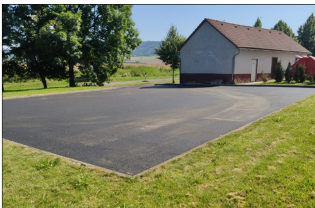
❑ Na parkovišti u hřbitova byl položen nový asfaltový povrch
