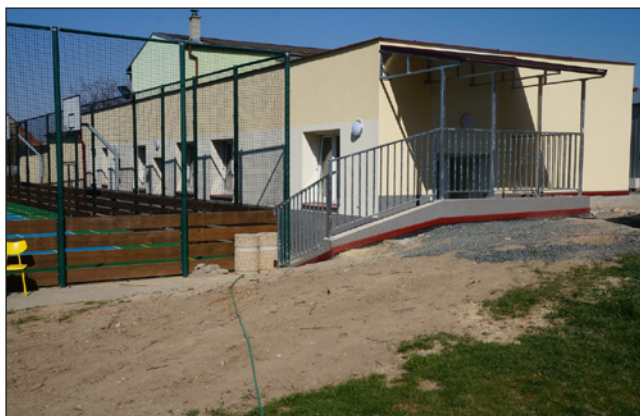
❑ Rekonstrukce dílen základní školy
