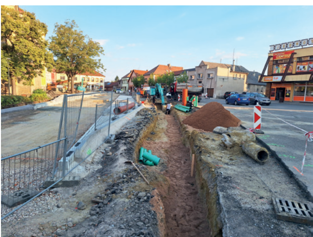
Na náměstí stále probíhá stavba silnice.
