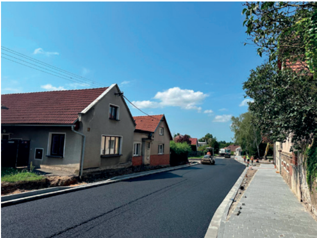
V Čáslavské ulici se pokládá finální asfaltový povrch silnice. Zároveň se pokládá zámková dlažba nového chodníku.
