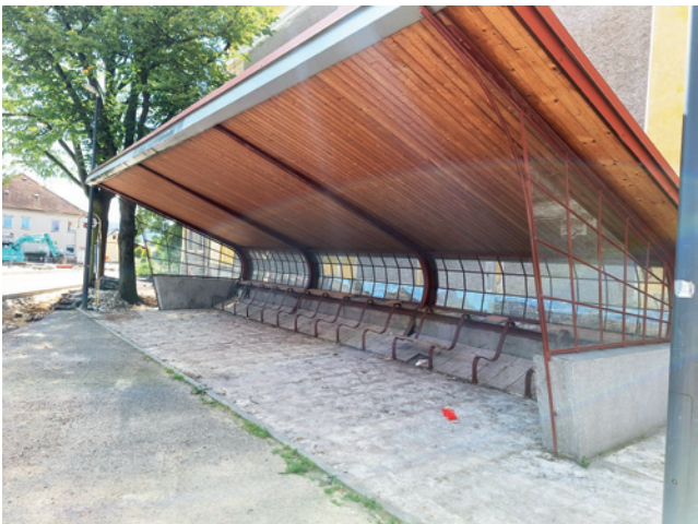
U autobusové zastávky byla odstraněna nepraktická, věčně špinavá dlažba. Stávající světlou dlažbu nahradí žulová mozaika. K této mozaice bude přizpůsobena výška lavičky, tak aby byla pohodlná pro sezení. Prostor kolem čekárny bude dodlážděn od kostela až k nástupnímu ostrůvku odsekovou dlažbou.
