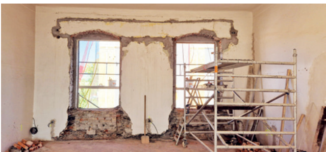
Zasedací místnost a tzv. „přípravna“ na MěÚ prochází rekonstrukcí.
