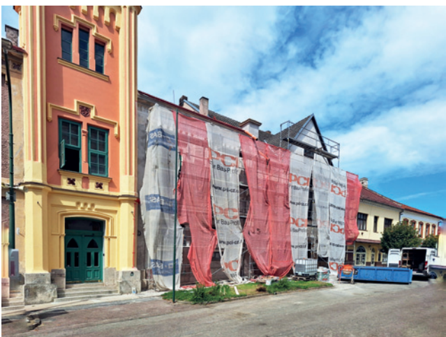
Probíhá oprava fasády další části radnice a sousedního domu.
